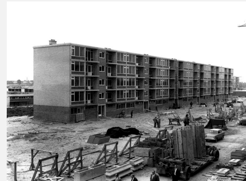
Foto's van portiekflats en galerijflats uit de jaren '50 en '60.
